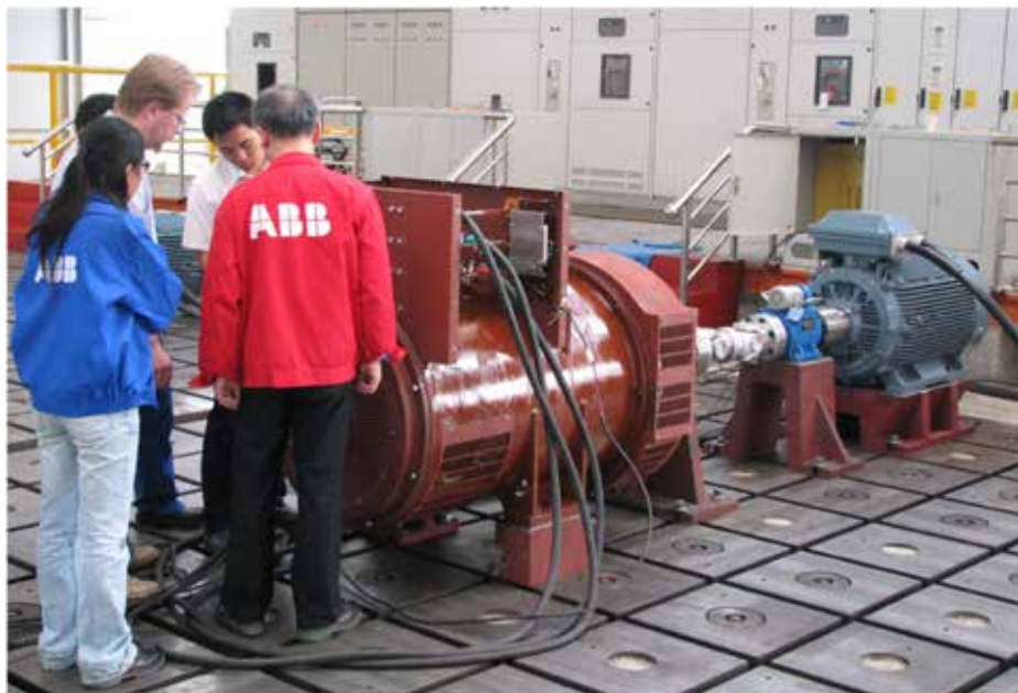
Испытания низковольтного генератора на заводе
