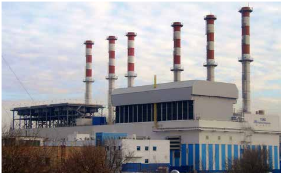
ТЭС «Международная», Москва Сити. Генераторы АББ с составе ПГУ. Суммарная мощность 240 МВт
