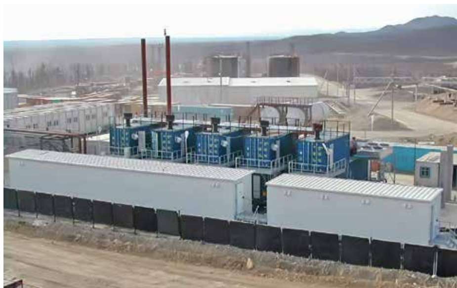
Рис. 4. Пример модульного решения мини-ТЭЦ, Дальний Восток, расчетная температура -54 °С
