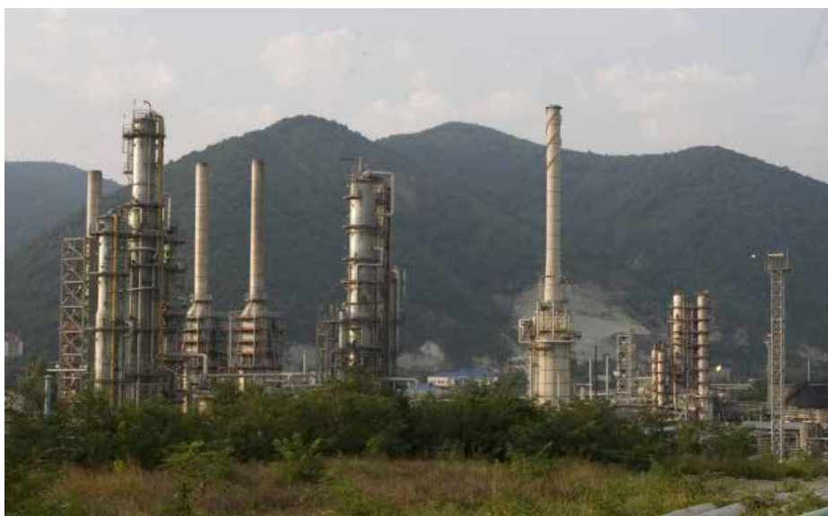
Туапсинский НПЗ ОАО «Роснефть». Краснодарский край. 6 генераторов АББ мощностью 47 МВт каждый
