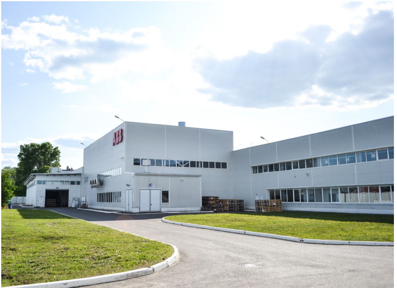
Завод АВВ в г. Хотьково Московской области
