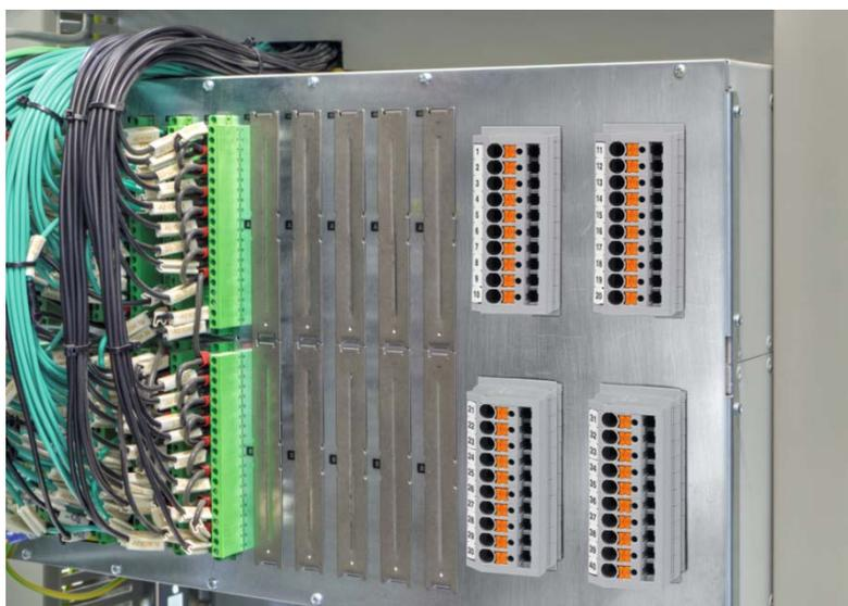
Вид на тыльную сторону терминала РЗиПА
