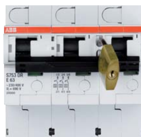
Фиксация заблокированного положения с помощью навесного замка
