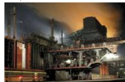
Подстанция 110\10 кВ, «Коксующий уголь» Кемеровская область, ООО «Кокс Майнинг»
