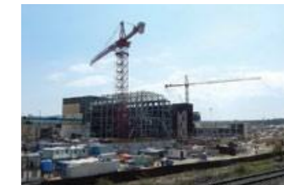
Пункты распределительные ПГУ-ТЭС г. Севастополь
