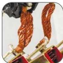
Внутренние токоведущие части из электротехнической меди
