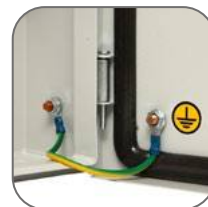
Обмедненные шпильки заземления. Закрепленный проводок заземления
