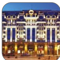
Защита высотных домов и гостиничных комплексов
