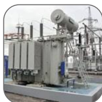
Объекты энергетической отрасли
