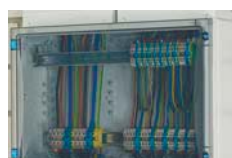
Клеммы для вводных/ отходящих кабелей
