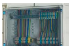
Клеммы для вводных/отходящих кабелей
