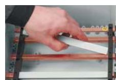
Изолирующие крышки на токоведущие шины для защиты от прикосновения
