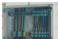
Клеммы для вводных/отходящих кабелей
