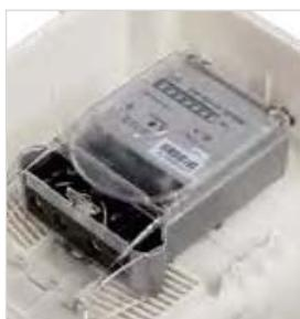
Установка счетчика на монтажную панель и на DIN-рейку.
