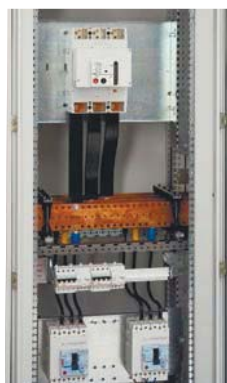
Шкаф Кат. № 0 472 53 с лицевыми панелями XL 3 , суппортом Кат. № 0 472 82 и комплектом стоек Кат. № 0 474 80
