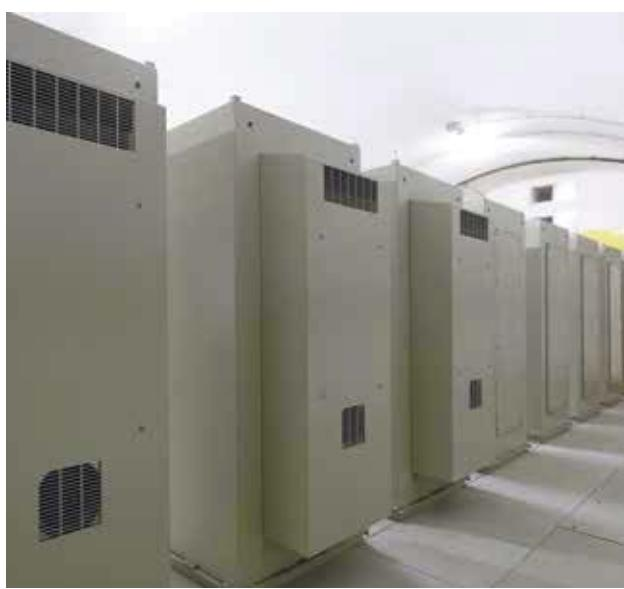
Разработка концепции климат-контроля электрических шкафов для 57-километрового Готардского скального тоннеля в Швейцарии. Максимальная пропускная способность маршрута: более 300 грузовых и пассажирских поездов в день на скорости от 160 км/ч до 250 км/ч, с трехминутными интервалами в течение дня.
