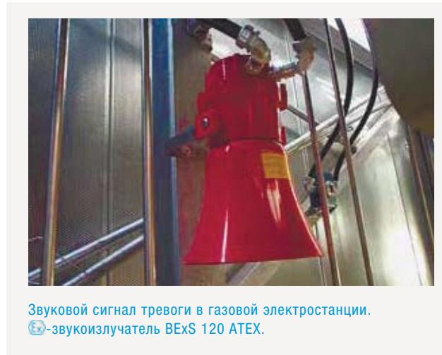
Звуковой сигнал тревоги в газовой электростанции.
